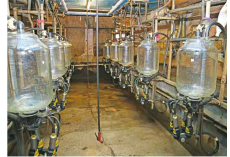
Net als de stal stamt ook de 2 x 6 stands visgraatmelkstal uit 1973. John is weliswaar voornemens een nieuwe 2 x 10 stands visgraat melkstal te bouwen, maar zegt evengoed met plezier twee keer daags 2,5 uur in de melkput te staan.
