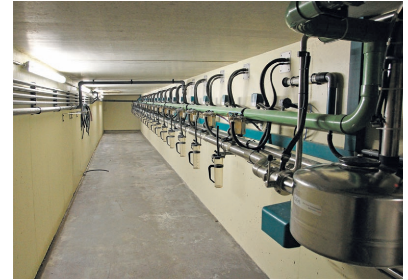
Leidingwerk, melkmeters et cetera zijn weggewerkt in de subway. Die is verwarmd: zo blijft de apparatuur vorstvrij. De verwarming dient meteen ook als vloerverwarming voor de melkers.
