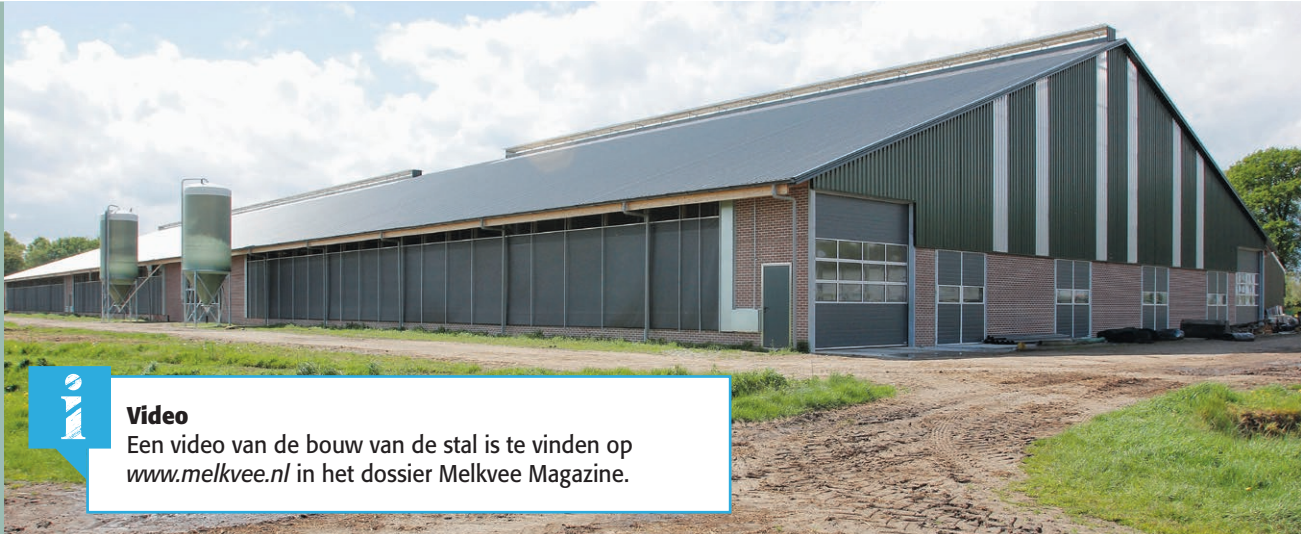
De nieuwe stal voor 480 koeien is 134 meter lang en 39 meter breed. Omdat er met personeel gewerkt gaat worden, zijn er op brandweervoorschrift extra zijdeuren aangebracht.
